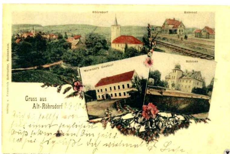
Widok na kościół, pałac, dworzec oraz budynek dzisiejszej świetlicy
